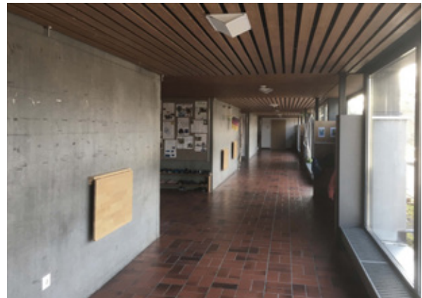
Gang Zwischen den Klassenzimmern im EG
