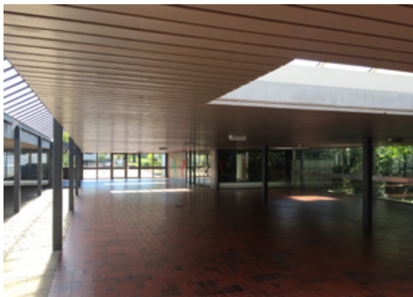
Pausenhalle mit Blick auf den Eingang Haldenweg
