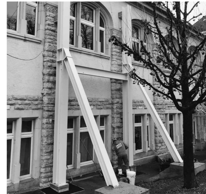
Stahlstützen zur Stabilisierung an der Aussenfassade
