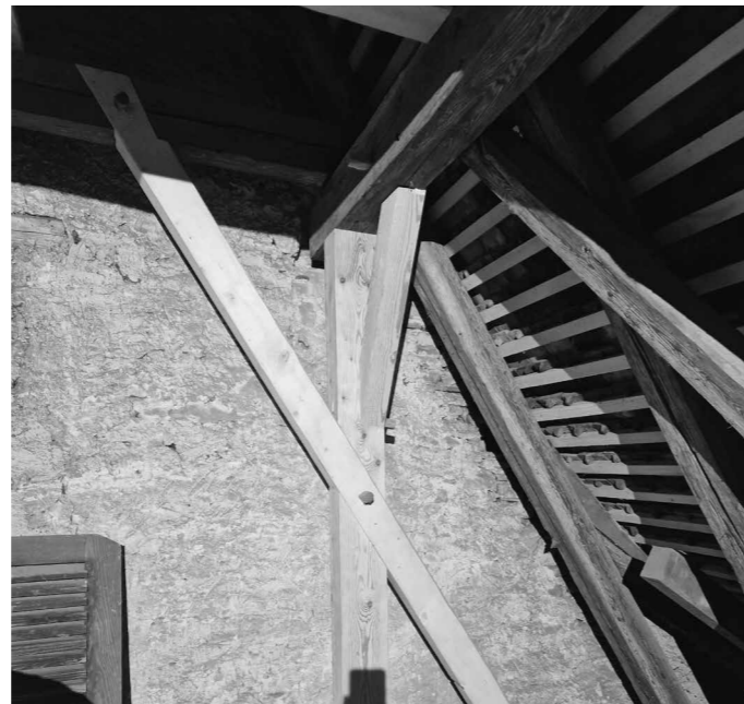
Restaurationen im Dachstock
