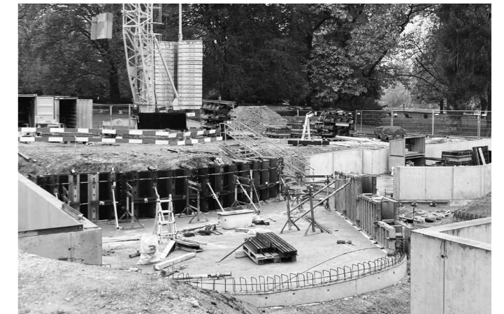
Betonierarbeiten am Becken des neuen Weihers
