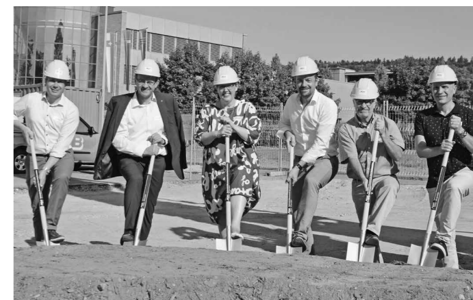
Spatenstich Wärmezentrale «Chloosfeld» mit Vertretenden der Stadt, der Abima Management AG sowie der AEW Energie AG
