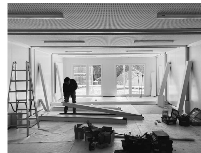
Montagearbeiten im modularen Schulraumprovisorium
