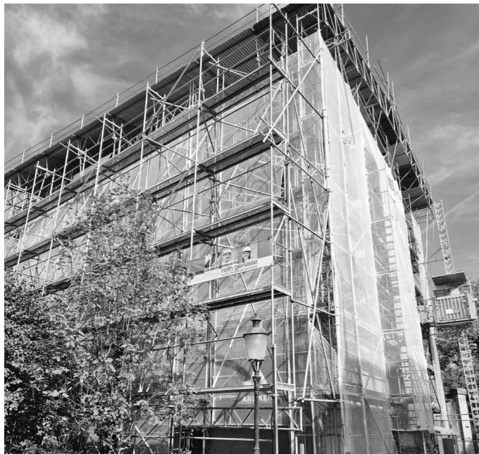
Johanniterkapelle mit Gerüst und Notdach
