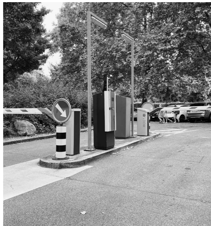
Die Parkschrankenanlage Schützenweg wurde Ende September zurückgebaut.
