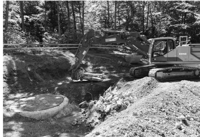
Rückbau des Pumpwerks Wäberhölzli II
