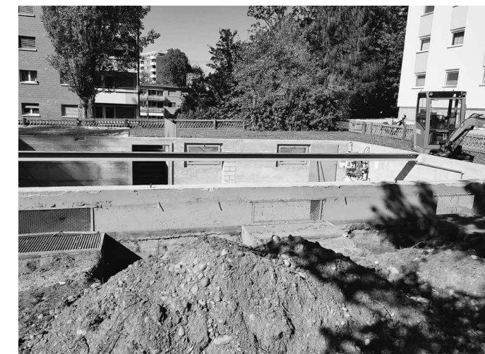
Das Fundament für den neuen Doppelkindergarten wurde im Herbst 2020 gelegt.
