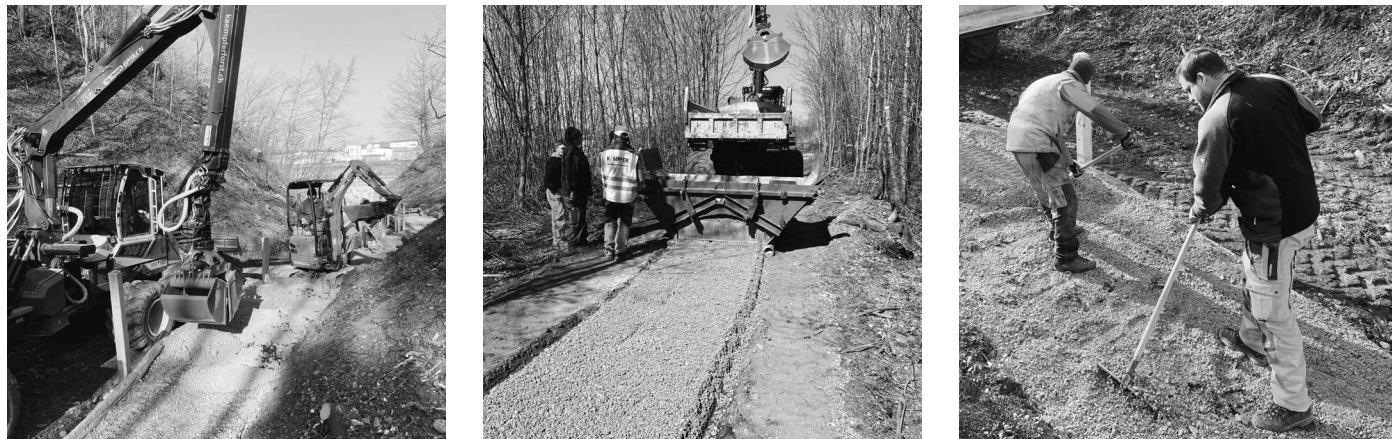
Die trockene Witterung begünstigte die Bauarbeiten, sodass der Fussweg schon vor Ostern fertiggestellt werden konnte.
