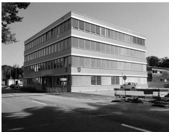
Neues Sicherheitsgebäude an der Riburgerstrasse 4
