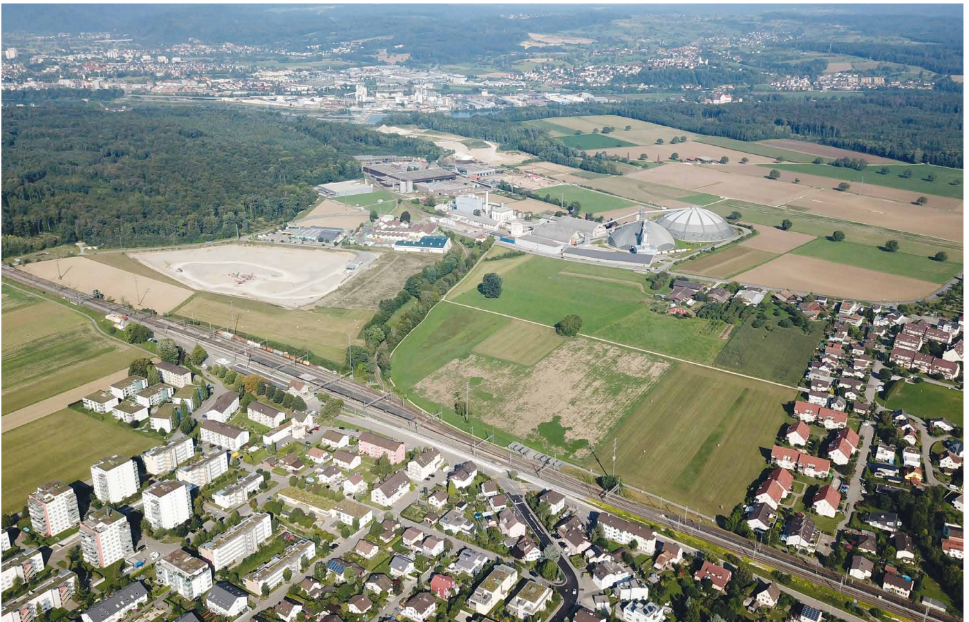
Testplanungs-Areal nördlich des Bahnhofes Möhlin im Grenzgebiet der Stadt Rheinfelden und der Gemeinde Möhlin
